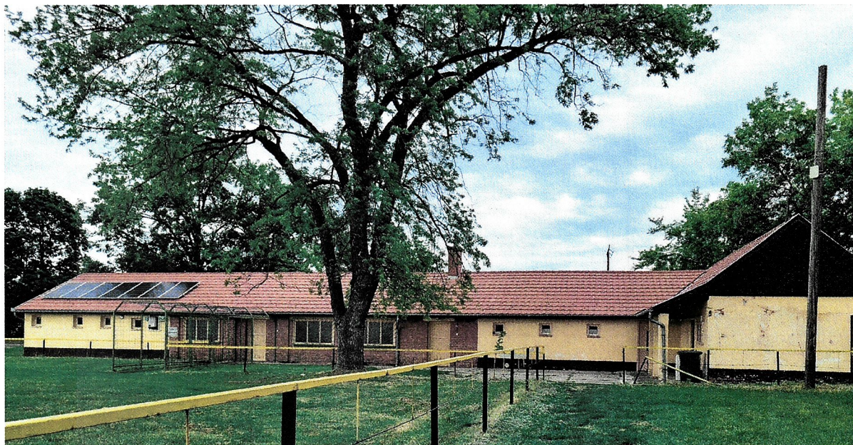
Az elkészült tetőfelújítás a visszahelyezett napelemekkel
